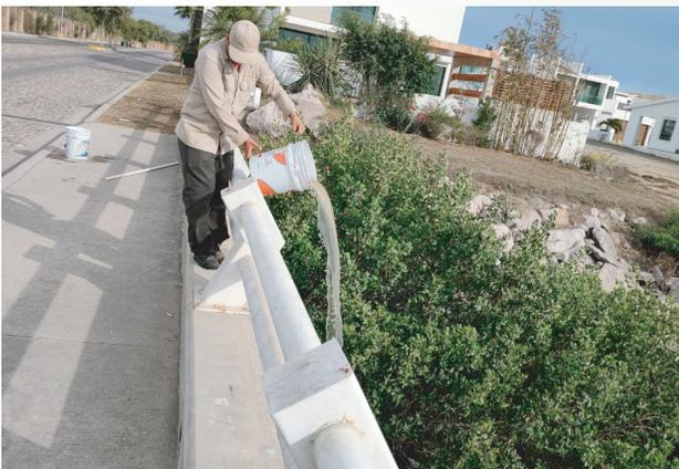
Trabajos, limpieza del Arroyo del Seminario: Aplicación de BDM-50, un químico acelerador del proceso de biodegradación de las materias orgánicas (aguas residuales).
