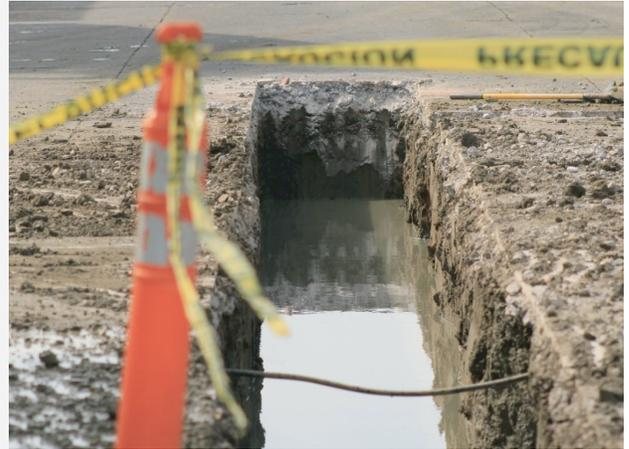
Reparación de dos tramos de calle por reparación de fugas en calle de Colina.
