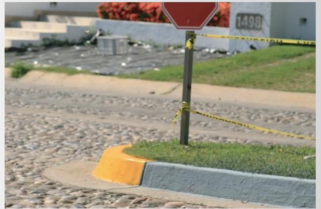
Reparación y mantenimiento del cruce alzado para carritos de golf, por el Circuito Julio Berdegué Aznar, por las casas 1279 y 1495, así como el de Sevilla, se hizo el cambio total de las piezas de adoquín color rojo, guarniciones y rampas laterales.
